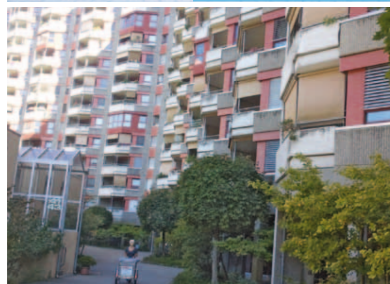
Eingang Provisorium Holenackerstrasse 27
